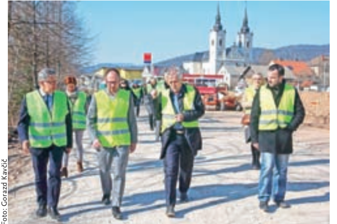
Minister za infrastrukturo Jernej Vrtovec si je v družbi žirovskega župana Janeza Žaklja ogledal gradbišče, na katerem nadaljujejo gradnjo obvoznice proti Logatcu.
