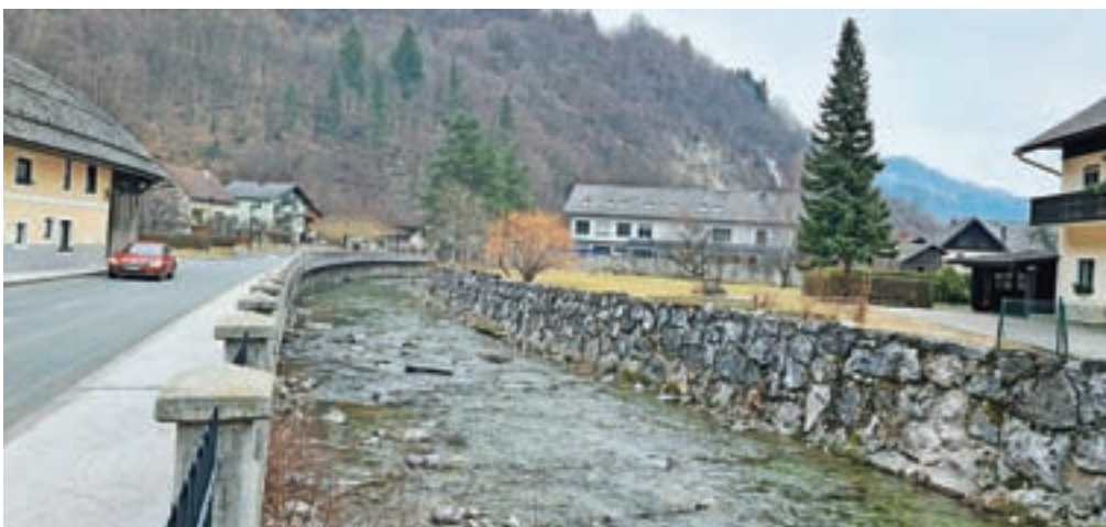
Prilagodljiva dela na odseku Selške Sore med Domelom in Dermotovim jezom se bodo začela v tem tednu, aprila pa bodo začeli dela v sami strugi.
