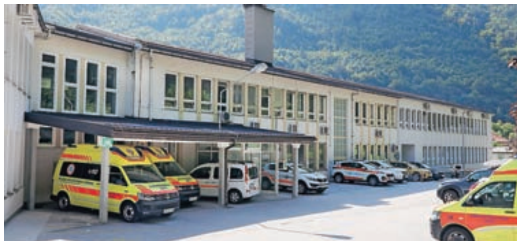
Gradnjo prizidka k ZD Tržič naj bi zaključili do konca leta 2023. / Foto: Tina Dokl, arhiv Gorenjskega glasa
