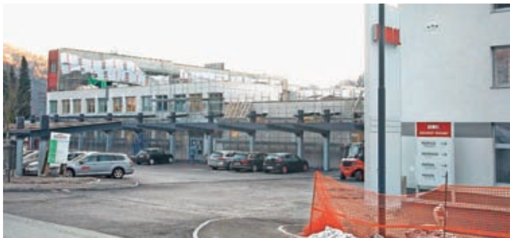
V Domelu so se že lani lotili urejanja dvorišča in energetske sanacije stavb, letos pa jih čaka še gradnja parkirišča v dveh etažah, ki je nujno potrebno za izboljšanje prometne ureditve.
