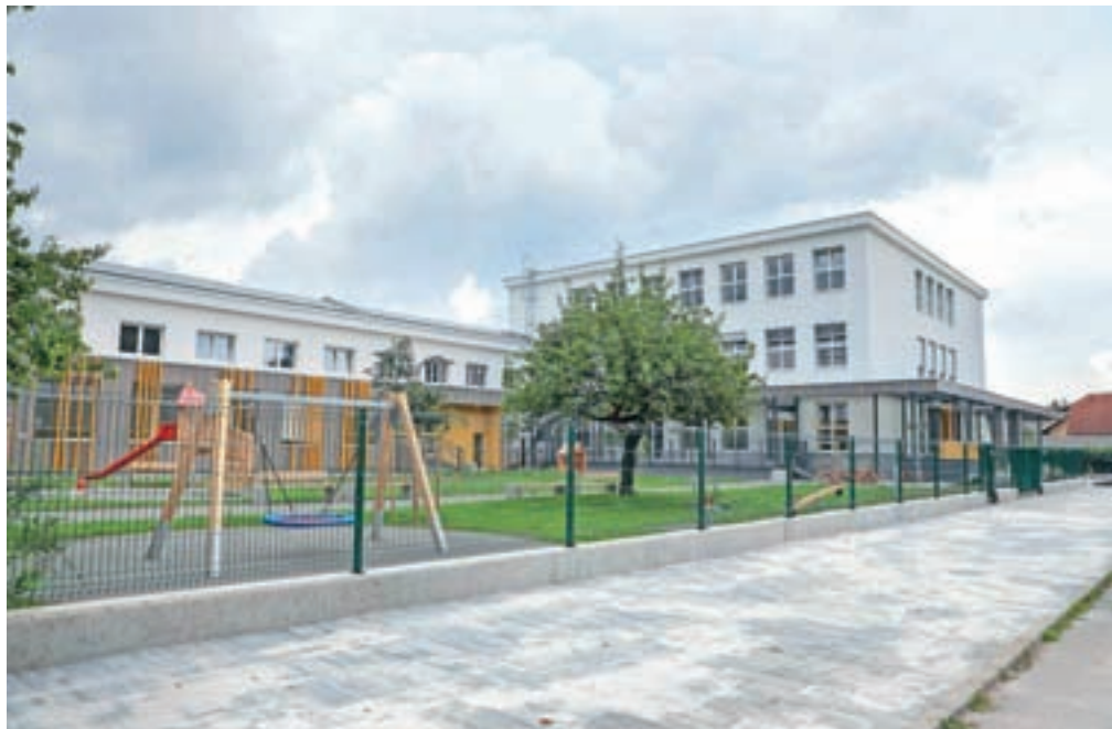
Prenova vrtca in Podružnične osnovne šole Simona Jenka Center v Kranju je končana, slavnostno odprtje pa bo v četrtek. / Foto: Tina Dokl
