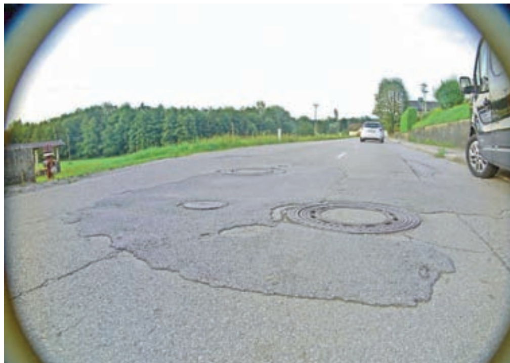
Problem ceste Rakovnik–Goričane je gravitacijska kanalizacija, ki poteka zelo globoko pod cesto. Jaški so ostali na višini, cesta pa se je posedla. Kanalizacija se je na tem območju gradila v letu 1988.
