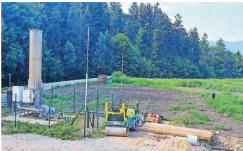
V zaključnem delu bodo nasuli še zemljinu in zatravili celotno polje.
