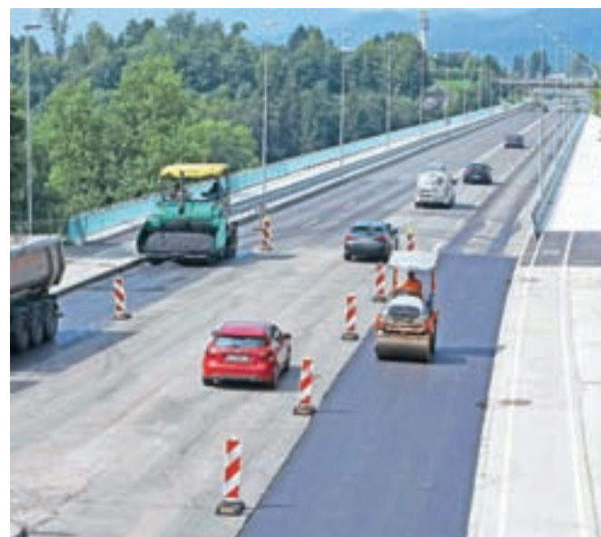
Zaradi polaganja asfalta na cesti od Delavskega mostu do križišča z nakupovalnim centrom Supernova Qlandia Kranj bo promet oviran še danes. / Foto: Gorazd Kavčič
