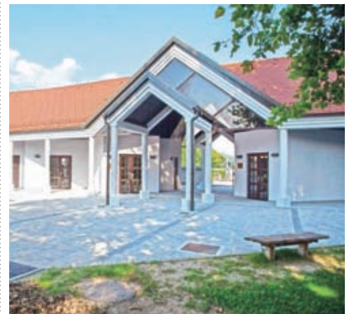
Obnovljeni objekt v Cerkljah
