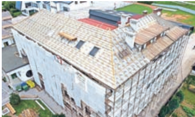
Obnova strehe na Osnovni šoli Koroška Bela
