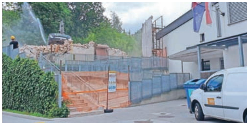
Portale iz 17. stoletja so s stavbe pred rušenjem odstranili in jih shranili, območje pa bo v nadaljevanju zatravljeno in namenjeno potrebam vrtca.
