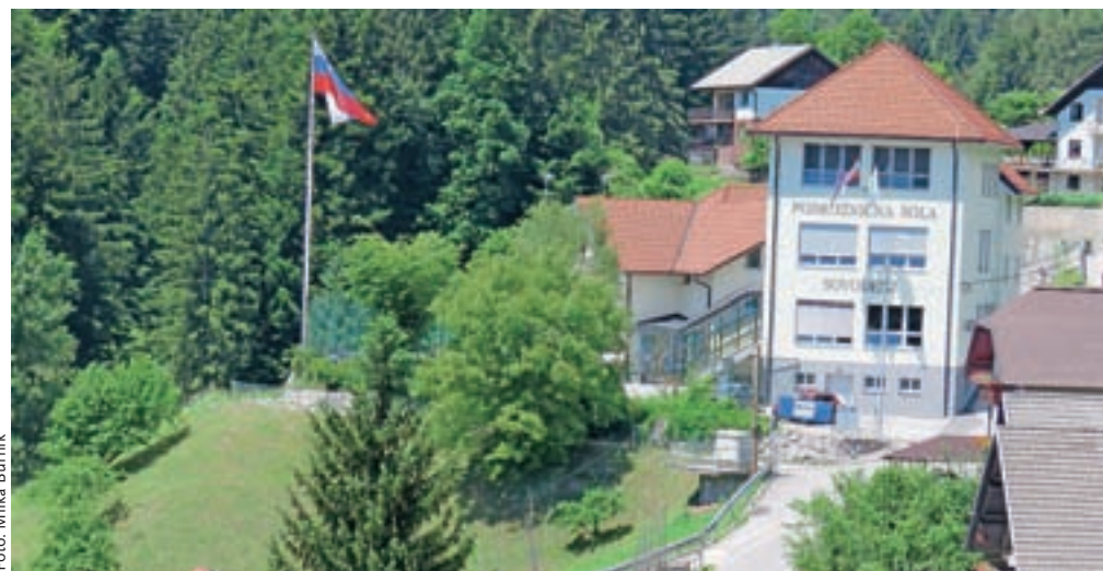
Ob zaključku obnove je na 18-metrskem drogu pred šolo zavihrala slovenska zastava.
