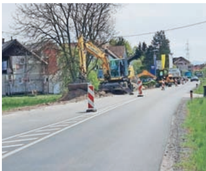
Gradnja pločnika v Dragomlju / Foto: Občina Domžale
