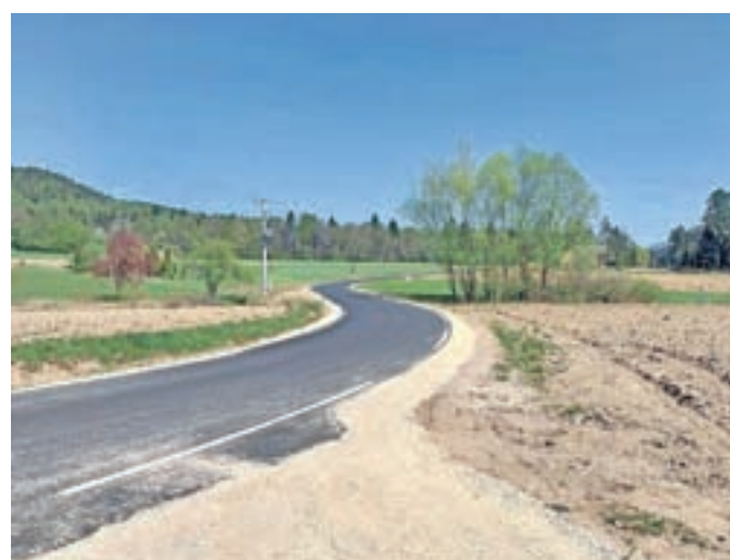
Cesta Rova-Dolenje že ima nov asfalt. / Foto: Občina Domžale
