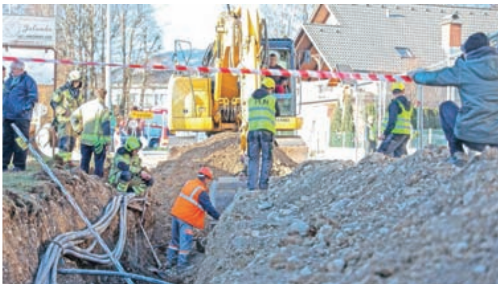
V Orehovljah je plinovod poškodoval delovni stroj pri gradnji komunalne infrastrukture, k čemur so prispevali tudi neusklajeni načrti podzemnih napeljav. / Foto: Tina Dokl
