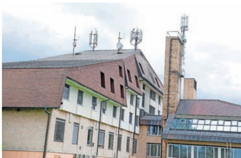
Sedanji Hotel Brdo je premajhen, stavba je dotrajana, energetska potratna in ekološko vprašljiva. / Foto: Tina Dokl
