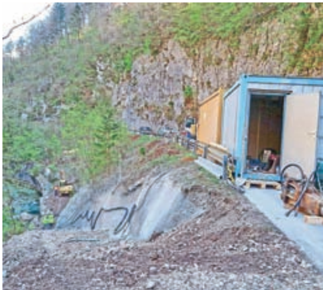
Promet v Kamniško Bistrico je zaradi sanacije brežine na odseku, kjer je gradbišče, urejen izmenično enosmerno.
