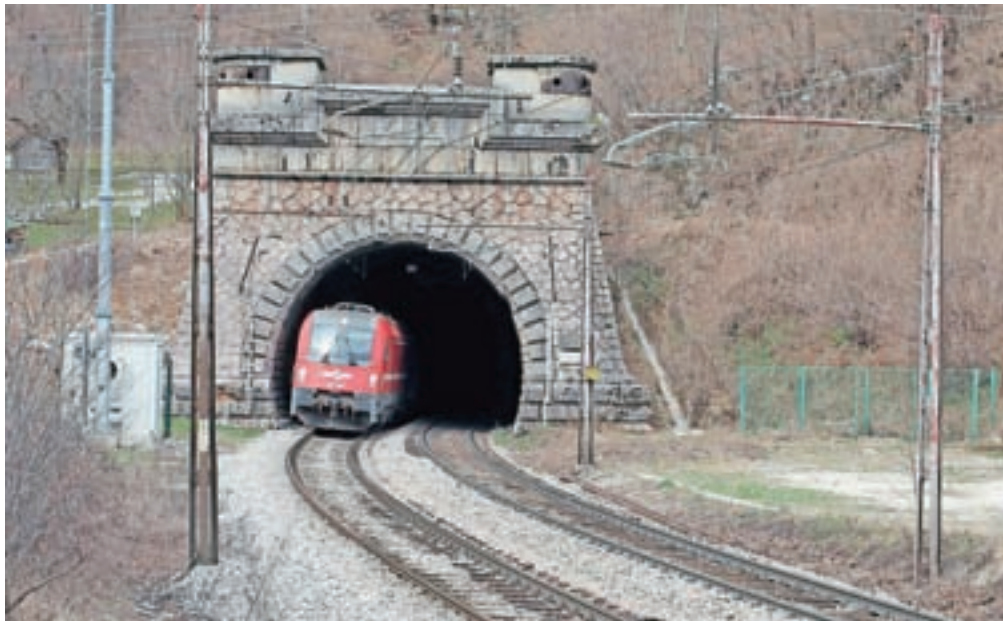
Karavanški železniški predor je zdaj dvotirni, a naj bi prihodnje leto en tir odstranili. Glede na prometne napovedi bo enotirnost proge v predoru Karavanke zadoščala vsaj do leta 2040, zatrjujejo na Direkciji RS za infrastrukturo. / Foto: Gorazd Kavčič
