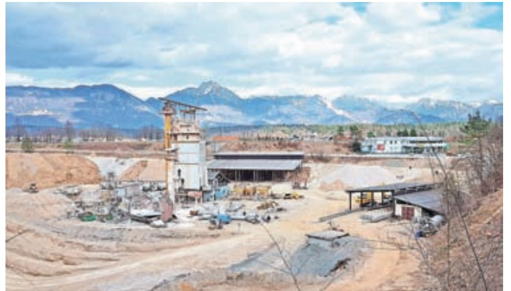
Razgradnja asfaltne baze v Podbrebru se zaključuje. Sledili bosta druga faza, zasipavanje, potem pa stanovanjska gradnja na tem območju. / Foto: Primož Pičulin
