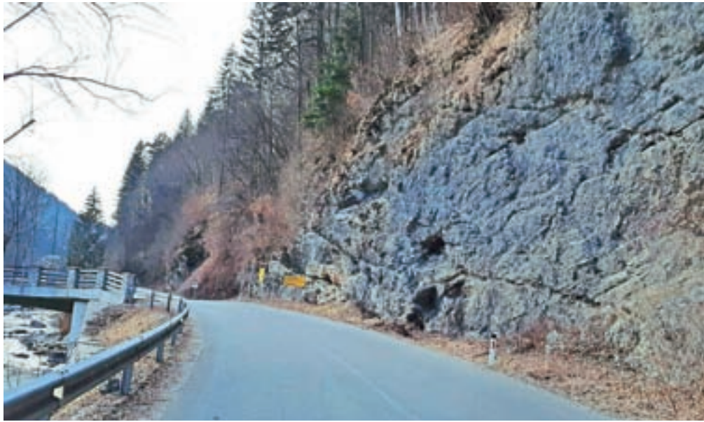
Pri odcepu za Davčo bodo odstranili del skalne brežine, sanirali podporni zid ob Selški Sori in uredili dobrih sto metrov ceste.
