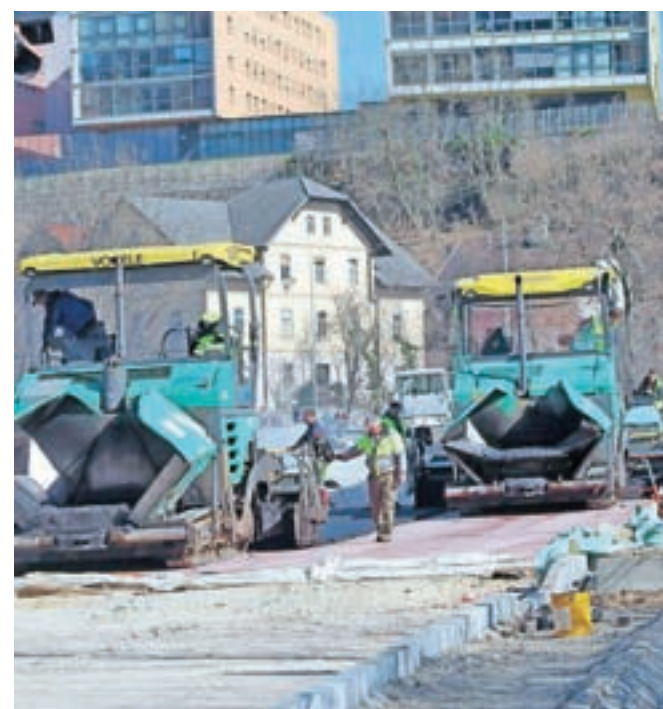
Na nadvozu nad Savskim otokom potekajo zaključna dela.
