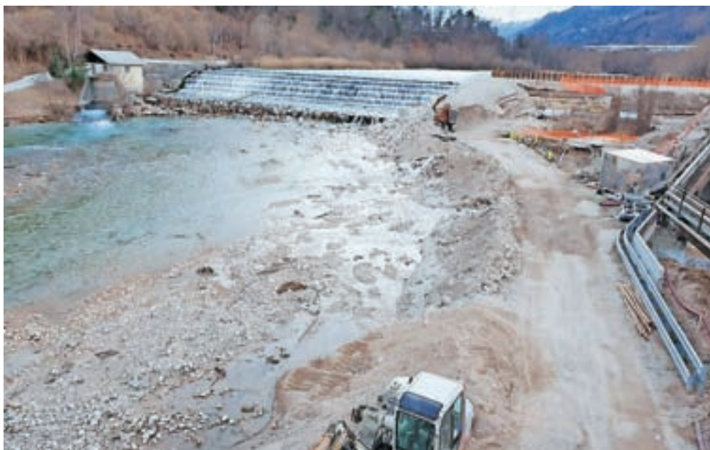
Projekt gradnje male hidroelektrarne na Savi Dolinki je izjemno zahteven, zgraditi so morali tudi varovalni nasip v strugi.
