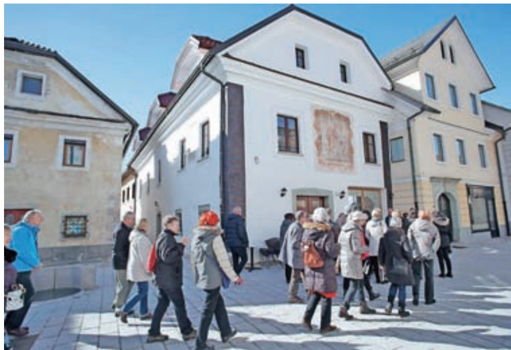
Družina Kolarič je Hotel Linhart v stavbi iz 17. stoletja na Linhartovem trgu v Radovljici uredila pred dvema letoma, letos so obnovili še fasado. / Foto: Gorazd Kavčič
