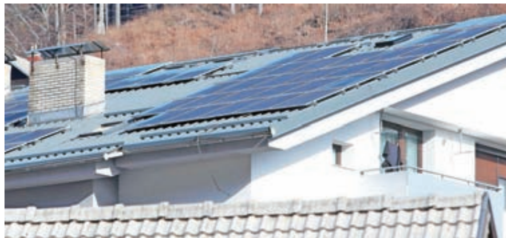
Na strehi bloka je 129 sončnih panelov, ki jih napaja sonce.
