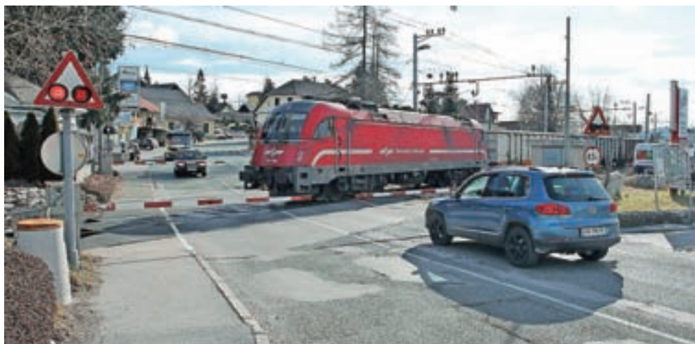
V sklopu obnove železniškega odseka med Kranjem in Jesenicami naj bi vendarle zgradili tudi podvoz za ves promet v Lescah, predvidoma ob območju nekdanje Verige; ko bo ta zgrajen, bo ukinjen obstoječi nivojski prehod na Alpski cesti v Lescah. / Foto: Gorazd Kavčič
