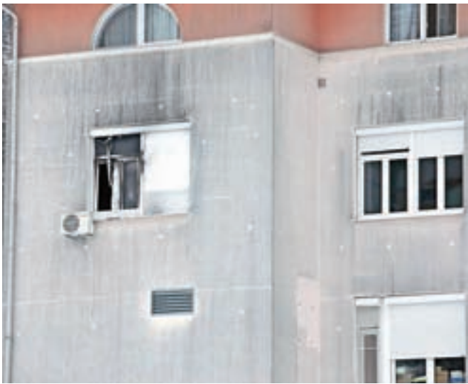
Požar je bil omejen le na eno bolniško sobo v tretjem nadstropju jeseniške bolnišnice. / Foto: Gorazd Kavčič
