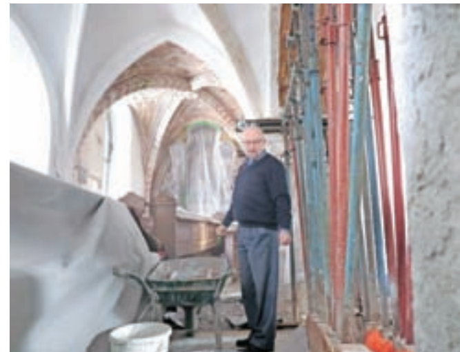
Najprej so se lotili obnove najbolj poškodovanega severnega dela cerkve, je povedal župnik Milan Kadunc.
