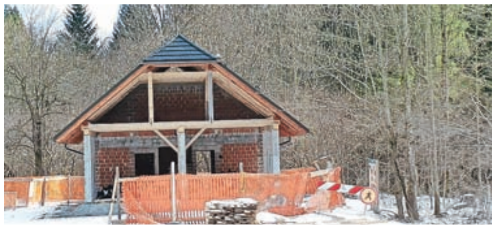
Na mestu, kjer je včasih stala manjša okrepčevalnica, so že zgradili stavbo, v kateri bodo uredili informacijski center s sanitarijami in manjši gostinski lokal.
