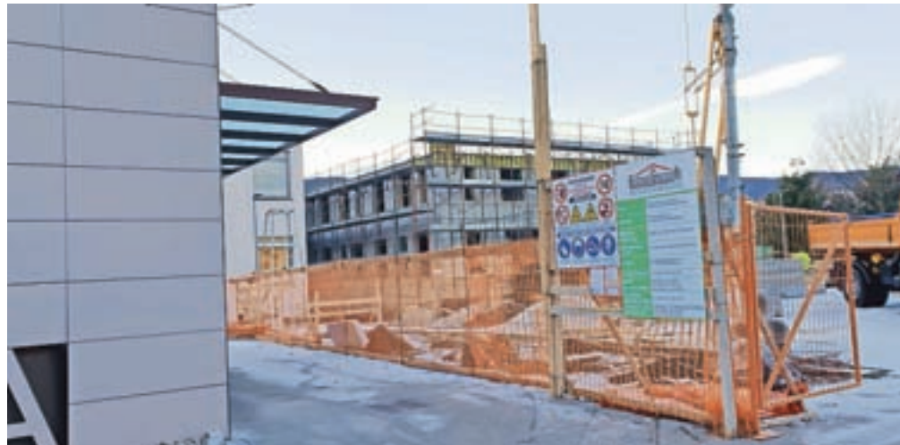
Rok za zaključek gradbenih del v prizidku k Zdravstvenemu domu Radovljica je 30. junij letos. V treh etažah (klet, pritličje, nadstropje) bodo prostori za ambulante s skupno neto tlorisno površino 855 kvadratnih metrov. / Foto: Marjana Ahačič
