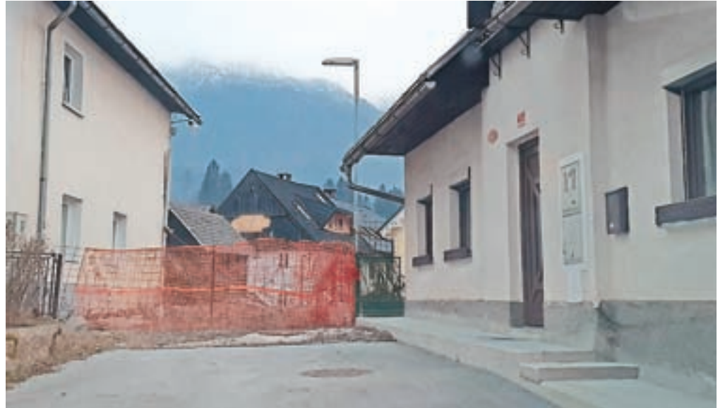
Grajska ulica v Bohinjski Bistrici bo do sodnega epiloga od hišne številke 4 naprej zaprta, hišo na naslovu Grajska ulica 6 pa so zaradi poškodb že porušili. / Foto: Andraž Sodja
