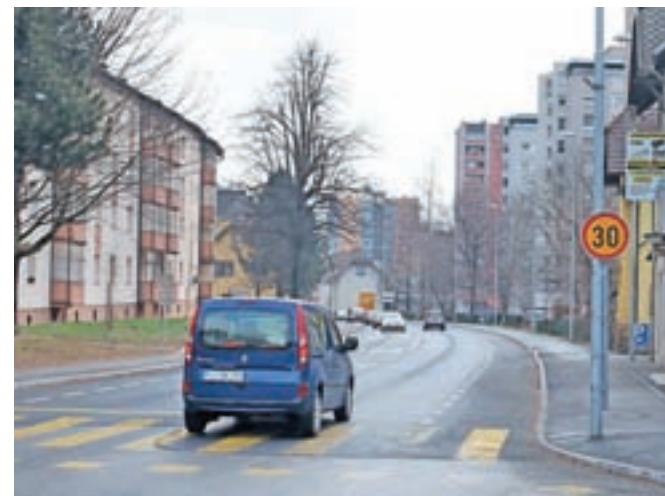
Obnovitvena dela so v večini zaključena, razen novega mostu. Odsek je zato še vedno gradbišče in velja omejitev hitrosti trideset kilometrov na uro. / Foto: Gorazd Kavčič
