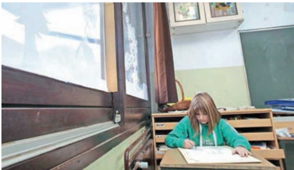
Špranje na povsem dotrajanih oknih v učilnicah so tako velike, da so jih zasilno prekrili z lesenimi deskami ... / Foto: Gorazd Kavčič
