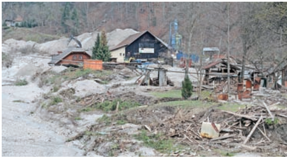
Pogled na hidroelektrarno in žago je žalosten, a obnovitvena dela že potekajo. / Foto: Tina Dokl
