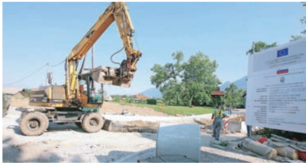
Občina Preddvor (na sliki gradnja komunalne infrastrukture) je bila v obdobju 2014–2017 sedma najbolj investicijsko naravnana občina v Sloveniji. / Foto: arhiv GG
