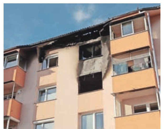
Ogenj je poškodoval dve stanovanji ter delno fasado in streho stanovanjskega bloka. / Foto: Luka Rener
