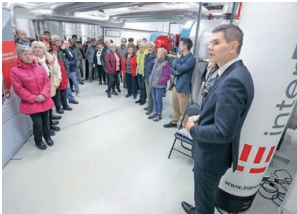
Uradna predstavitve celostne prenove ogrevalnega sistema v prostorih prav tako prenovljene skupne kotlovnice / Foto: Tina Dokl
