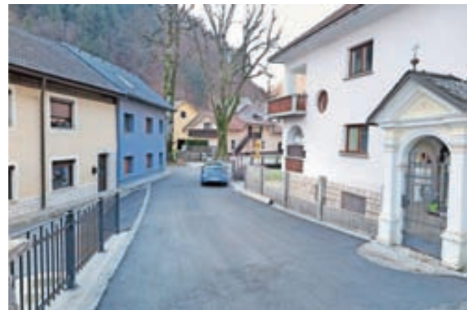
Ceste na Racovniku so dobile še zaključni sloj asfalta.
