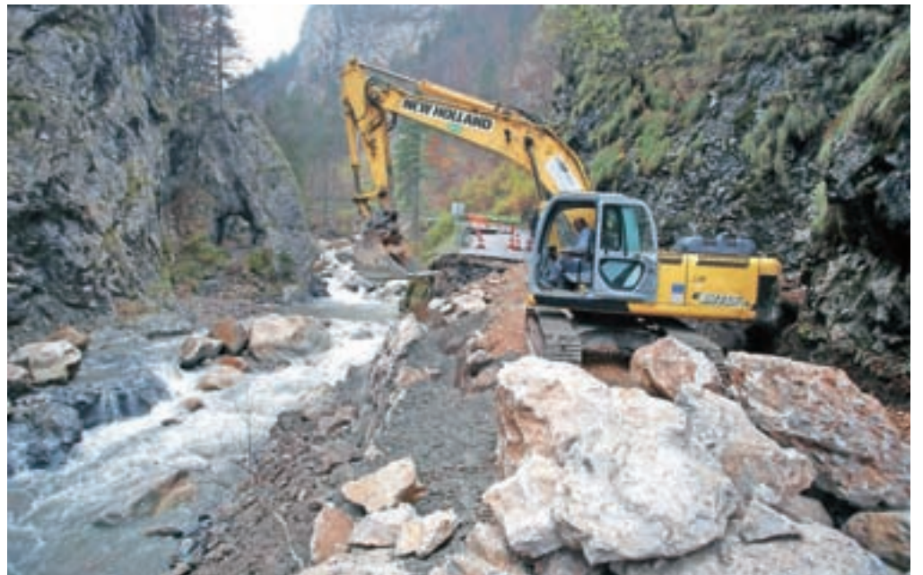
Delavci podjetja VGP utrjujejo in zasipavajo od ujme podprt odsek ceste v Dovžanovi soteski. Samo v nedeljo so na tem delu porabili sedemdeset kubičnih metrov betona in 110 kubičnih metrov skal. / Foto: Gorazd Kavčič
