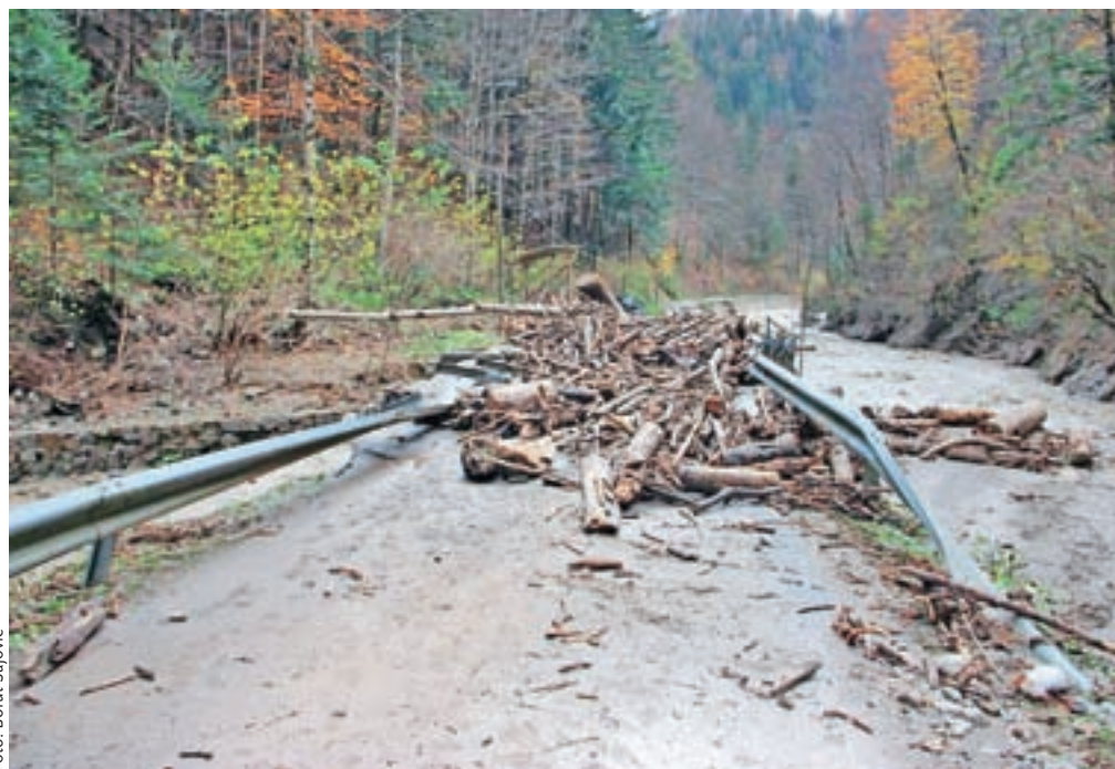
Nekajkrat presežena količina vode v Jelendolu je na cesto naplavila tudi ostanke sečnje.
