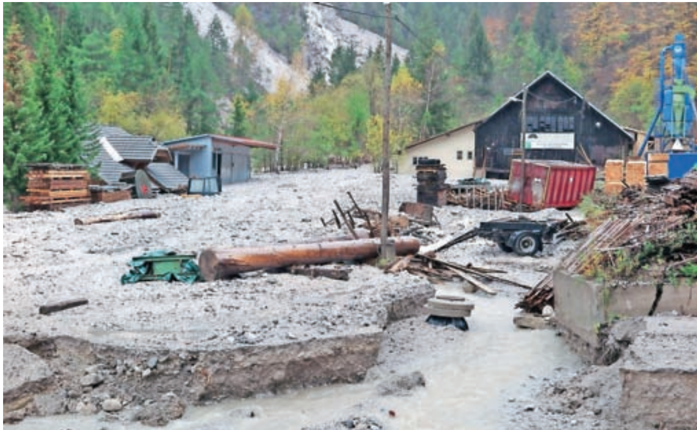
Vsi objekti in stroji žage in hidroelektrarne na Belci so bili zasuti z nekaj metri peska in uničeni. Največjo grožnjo pa predstavlja plaz nad vasjo. / Foto: Urša Peternel
