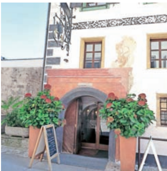
Stavba Mitnice ima prenovljeno pročelje, skrbijo pa tudi za okrasitev in rože pred vhodom.
