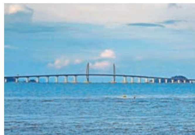
Najdaljši morski most na svetu, povezal je Hongkong in Macao. Vanj je vgrajenih 400.000 ton jekla, kar bi zadostovalo za šestdeset Eifflovih stolpov ... / Foto: Wikipedija
