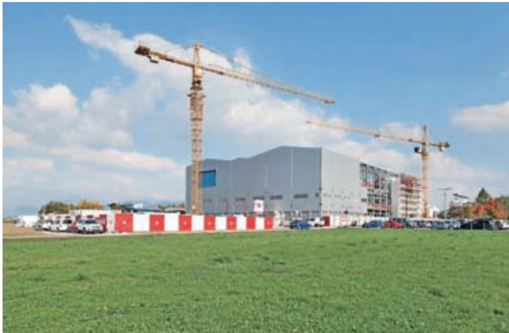
Z novim objektom v Biofarmaceutiki Mengeš bodo razširili proizvodno linijo bioloških učinkovin.
