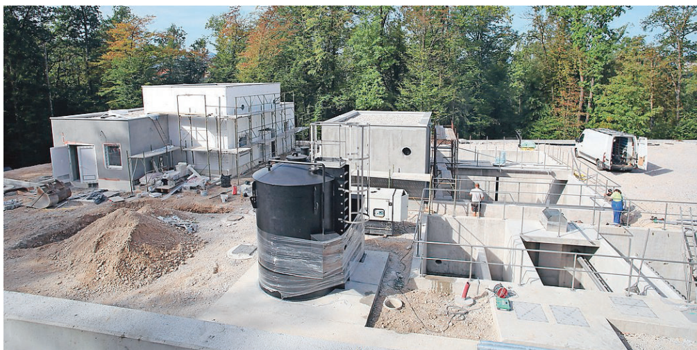
Čistilna naprava v Trbojah dobiva končne obrise. / Foto: Gorazd Kavčič
