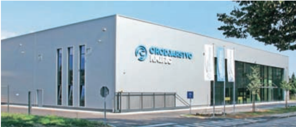
Novi proizvodno-skladiščno-poslovni objekt Orodjarstva Knifc v Naklem
