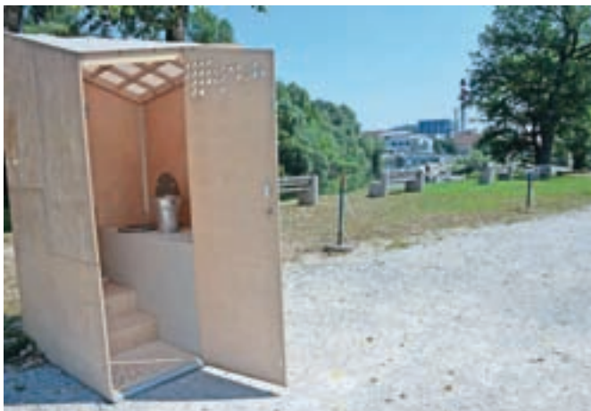
Sanitarije nove generacije so postavljene tudi v Goričanah. Po uporabi namesto splakovanja z vodo posipamo s suho snovjo.
