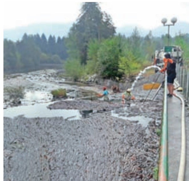
V petek so se domači gasilci lotili odstranjevanja smrdeče naplavine na Cajhnovem jezu na Lancovem. V Centralno čistilno napravo Kranj so odpeljali sedemdeset kubičnih metrov materiala. / Foto: Gasilska zveza Občine Radovljica
