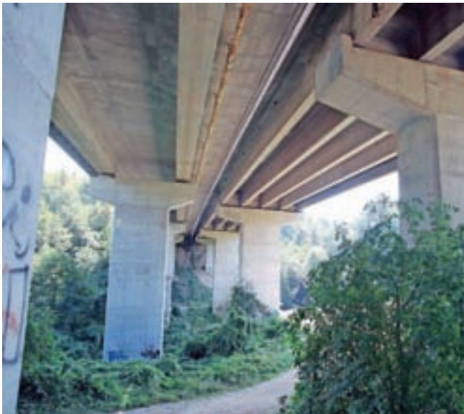
Najstarejši viadukt na gorenjski avtocesti je viadukt Rupovščica iz leta 1985. / Foto: Gorazd Kavčič
