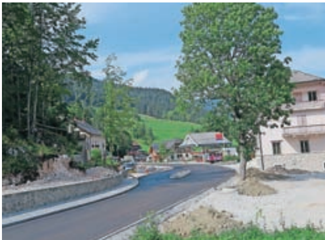
V torek so položili asfalt na obnovljenem odseku državne ceste skozi središče Jezerskega.
