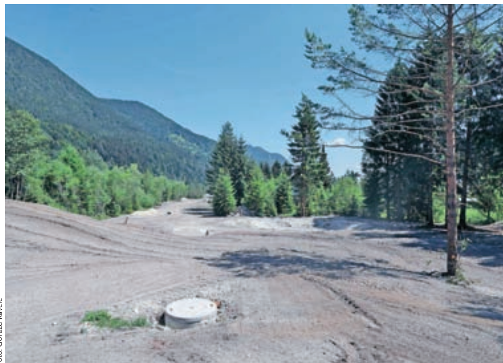
Igrišče za golf v Kranjski Gori bodo povečali za še enkrat, projekt je obsežen. Dela naj bi bila zaključena še letos, na novem igrišču pa bo mogoče igrati prihodnje leto.
