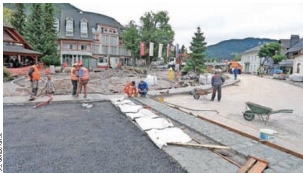
V teh dneh se zaključujejo obnovitvena dela na cesti skozi središče Kranjske Gore.
