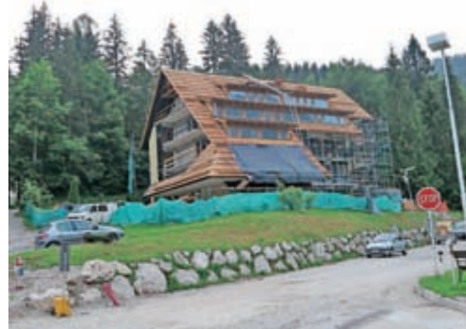
Na Jezerskem poteka obnova hotela Planinka. / Foto: Tina Dokl
