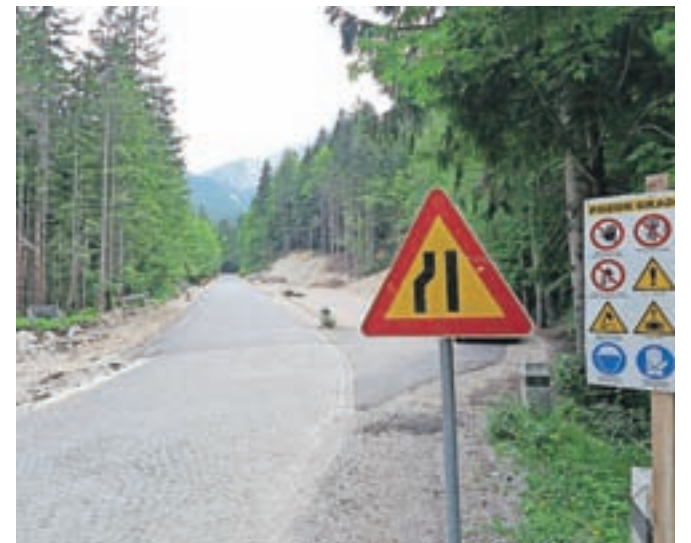
Večina obnovitvenih del na gorenjski strani ceste čez Vršič je že zaključena.
