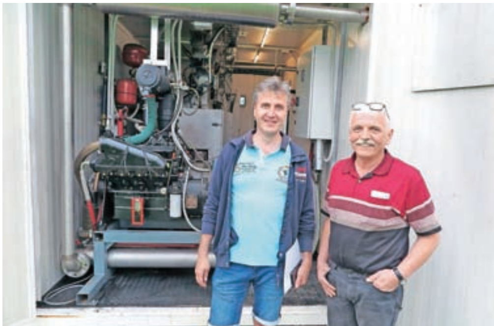
Michal Fričovský in Marjan Kežar pred inovativno elektrarno na sekance, ki je umeščena v kontejner.
