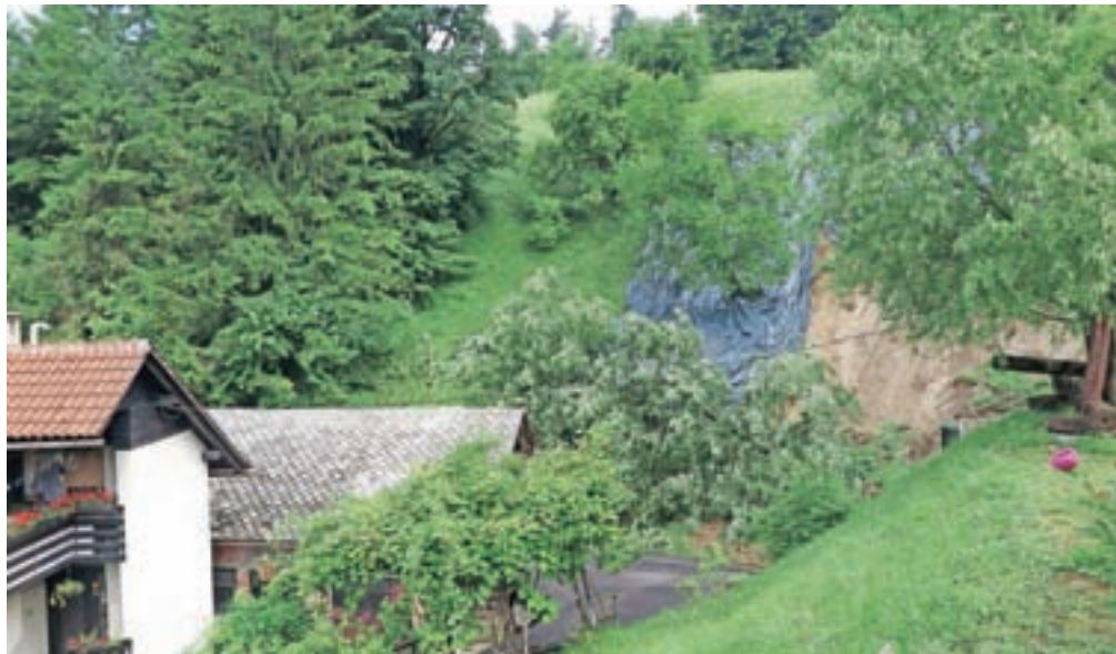
Zemeljski plaz, ki so ga gasilci že v torek zaščitili z gradbeno folijo, je porušil letno kuhinjo ob hiši, a stanovanjske stavbe ne ogroža več. / Foto: Jasna Paladin
