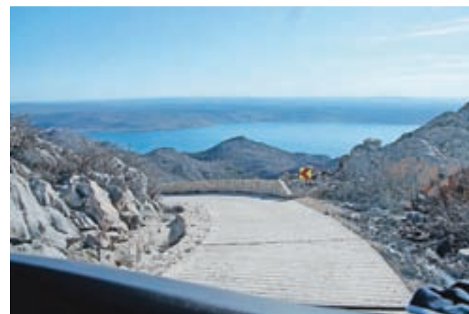
Določeni (pre)strmi odseki ceste na Veliko Rujno, če ji lahko tako rečemo, saj je bolj cestica, niso asfaltirani, temveč betonirani.
