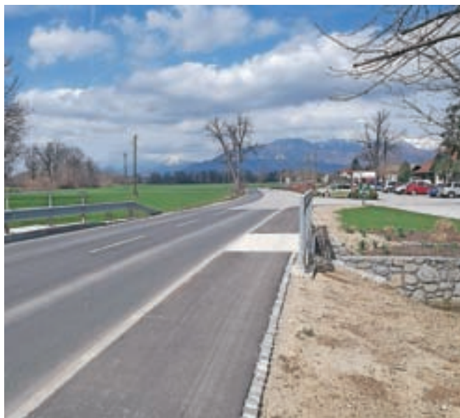
Prenovljeni prepust potoka Stanjšek nasproti vhoda v park Arboretum
