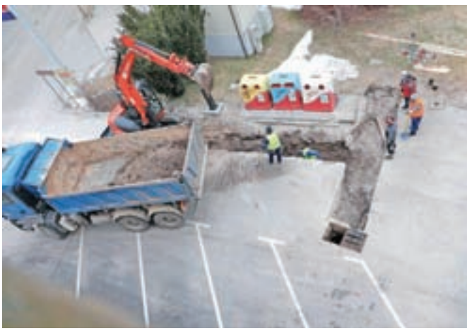
Na Jezerskem se z obnovo vodovoda začelja rekonstrukcija odseka državne ceste od občine do Korotana. / Foto: Tina Dokl
