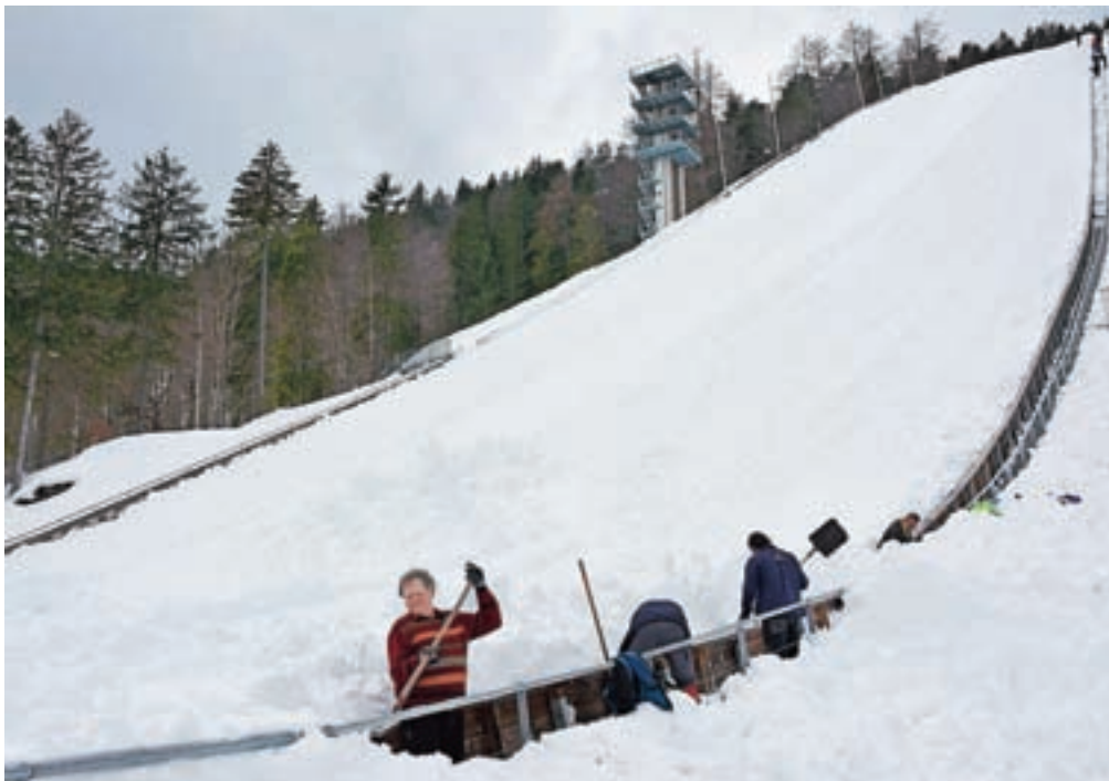
Planiški delavci letalnico pripravljajo na zaključek svetovnega pokala v smučarskih skokih, ki bo prihodnji konec tedna.
