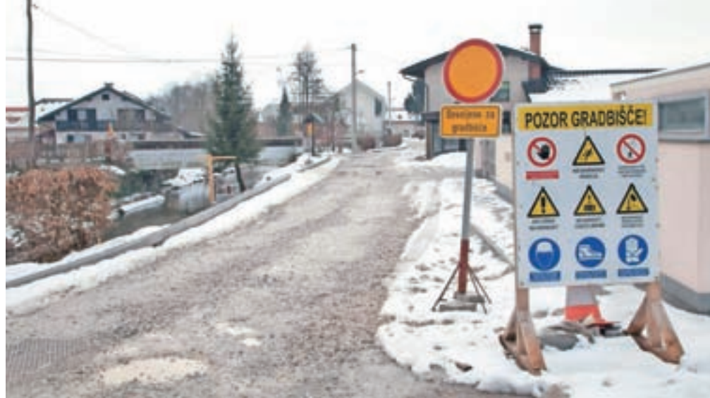
Po ureditvi cestne infrastrukture bodo dela na Ropretovi cesti v Mengšu končana.
