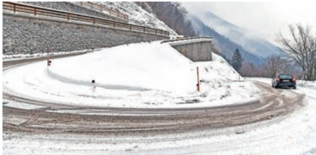
Soričani upajo, da bo cesta, ki so jo začeli graditi že pred dobrim desetletjem, letos večinoma dokončana. / Foto: Andrej Tarfila
