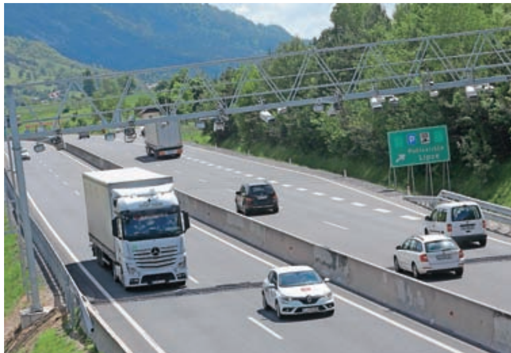
Elektronsko cestninjenje bo potekalo s pomočjo mikrovalovne tehnologije na 127 cestninskih portalih na avtocestah. / Foto: Gorazd Kavčič
