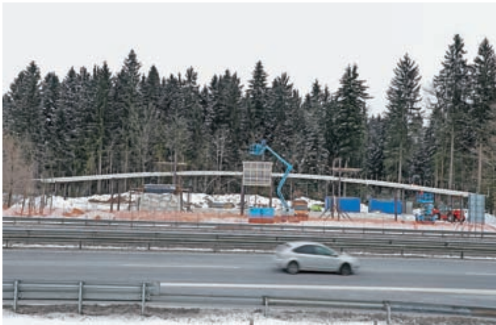
V Šenčurju na začasni lokaciji že sestavljajo jekleno konstrukcijo za prihodnji nadvoz nad avtocesto. / Foto: Tina Dokl
