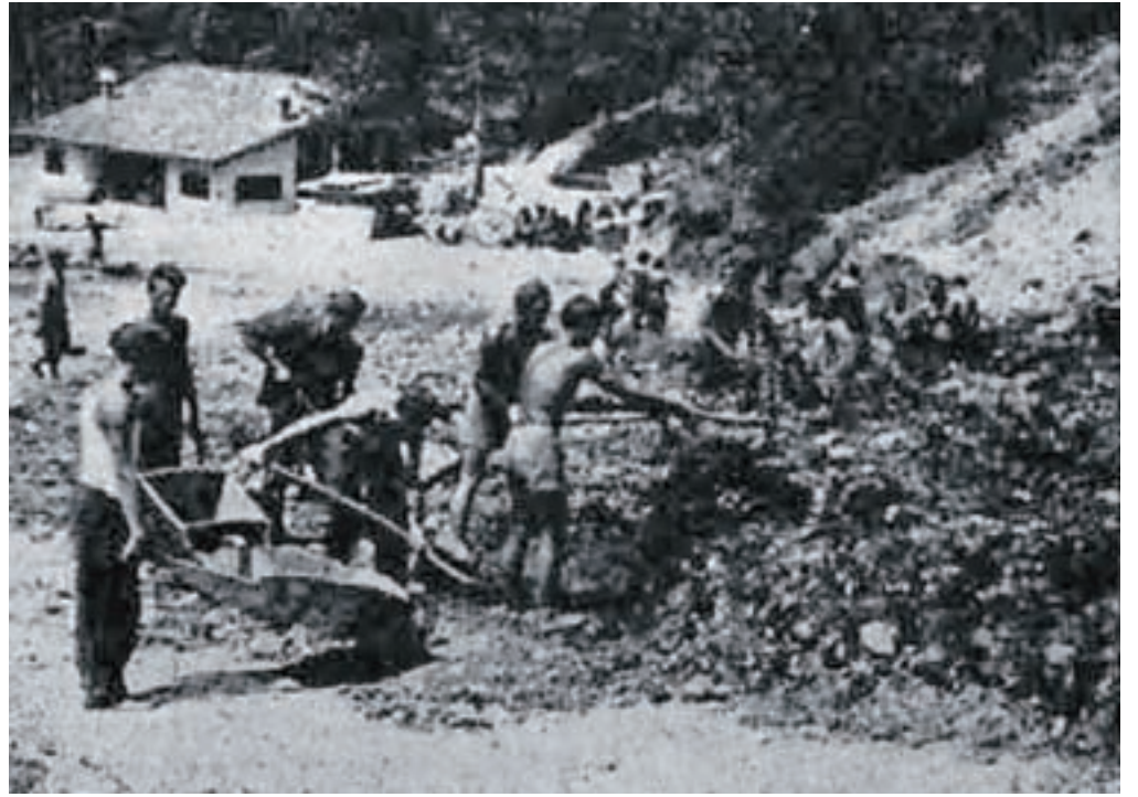
Urejanje cestišča in dovoza do spodnje postaje žičnice. / Foto: arhiv Gorenjskega glasa
