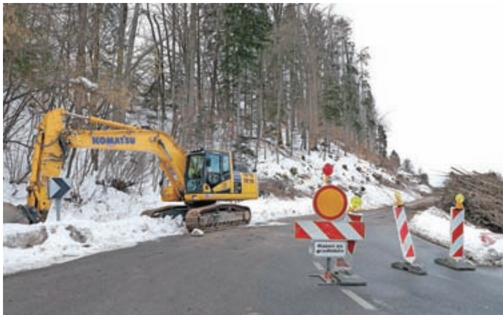
Zaradi obnovitvenih del na državni cesti je lokalni promet na Lancovem urejen enosmerno, med Radovljico in Lipniško dolino pa je urejen obvoz. / Foto: Tina Dokl
