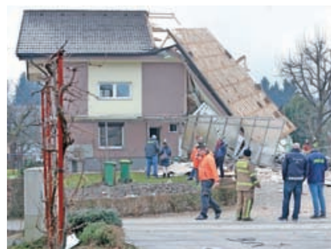
V eksploziji plina se je porušila približno polovica stanovanjske hiše. / Foto: Gorazd Kavčič
